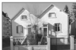
Rue de la Mairie, maisons jumelées
