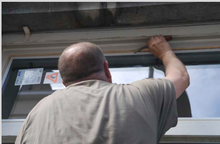
Chantier Rénover - sprl
