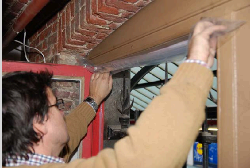
PARCOURS TECHNIQUE RÉNOVATION CHÂSSIS BOIS - 29.04-2014 - Jérôme BERTRAND
