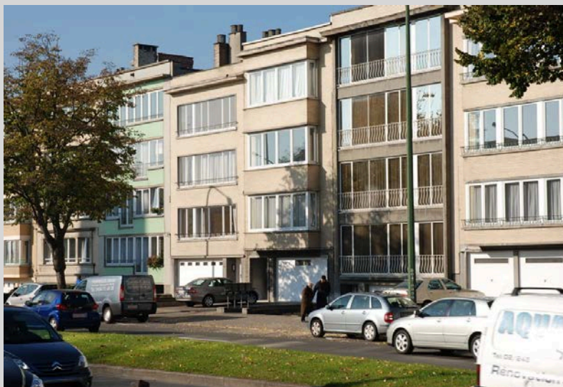
Wolluwé Saint-Lambert - Immeubles des années « 60 »
