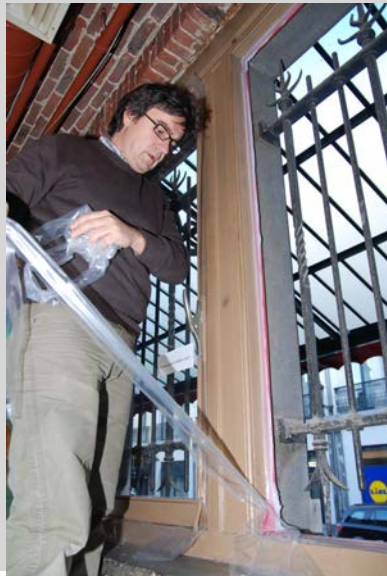
PARCOURS TECHNIQUE RÉNOVATION CHÂSSIS BOIS - 29.04-2014 - Jérôme BERTRAND
