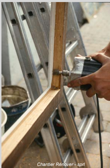
Chantier Rénover - sprl
