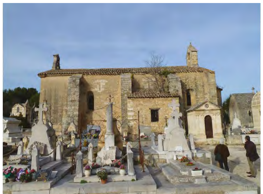
Fig. 3 : Vue générale extérieure de la chapelle avant travaux
