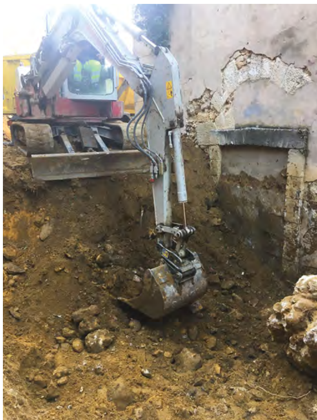
Figure 11 : Bédoin, Eglise St Pierre, déblaiements 2019
