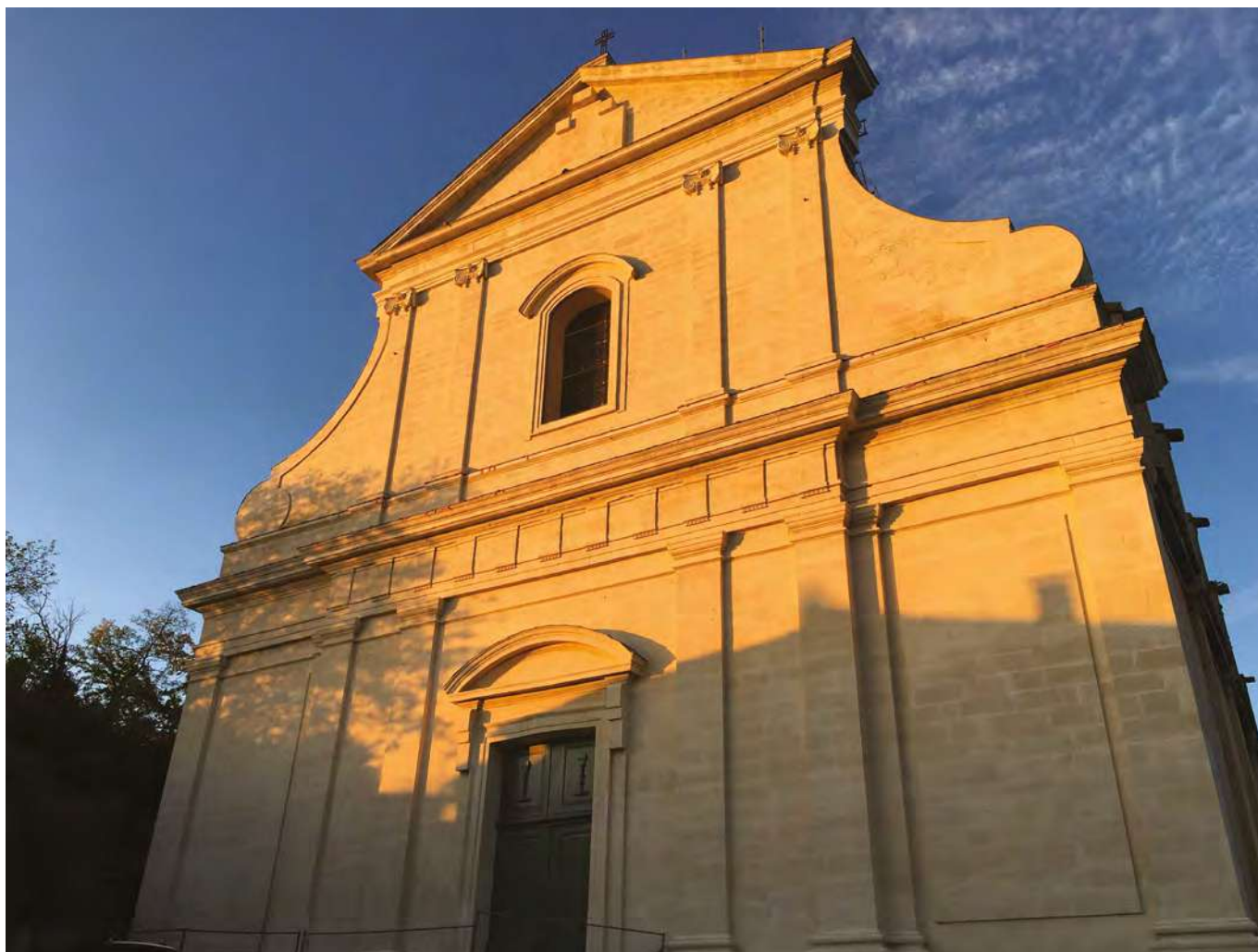
Figure 7 : Bédoin, Eglise St Pierre, façade sud après restauration 2019
