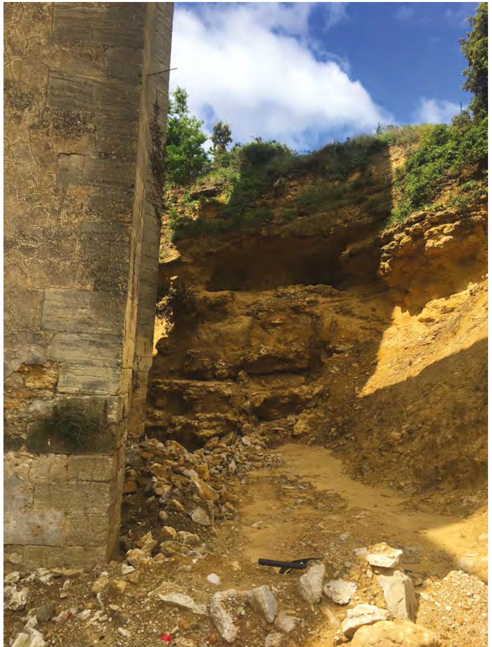
Figure 10 : Bédoin, Eglise St Pierre, remblai nord et talus 2019
