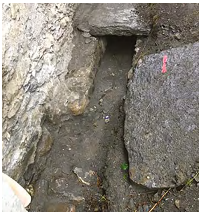
Fig. 2a - 2b : L'aqueduc-drain en cours de dégagement (2019) © Agence M. Trubert
