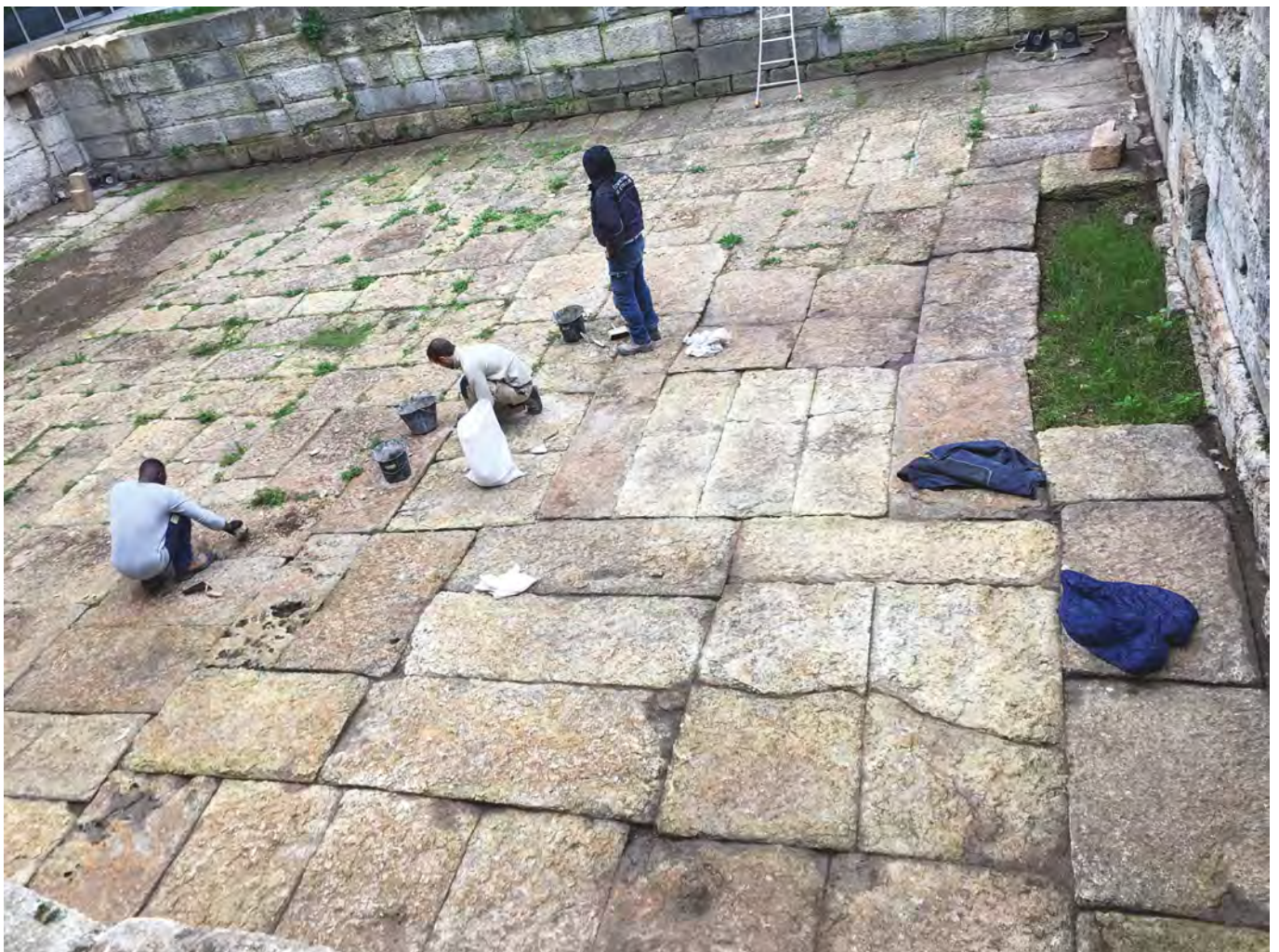
Figure 3 : Marseille Port antique, Bassin d'eau douce, avant travaux 2018
