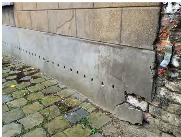
Figure 1 : Disposition des forages dans la maçonnerie (source CSTC NIT 252)
