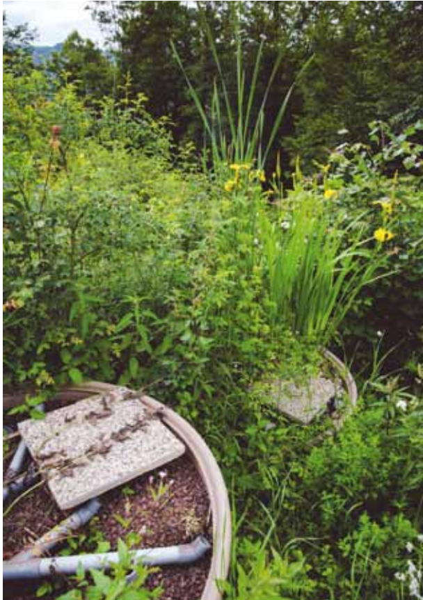
▲ Fig. 85 – Bassin filtrant en phyto épuration à Montavoix, Saint-Claude
