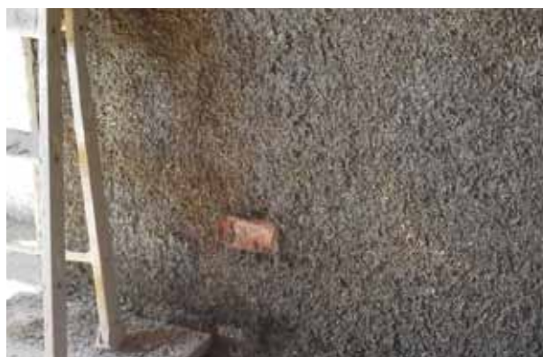
► Fig. 83 – Ouate de cellulose projetée humide en isolation d'un bâtiment ancien
