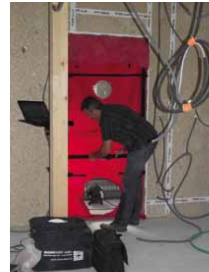
▲ Fig. 57 – Test d'infiltrométrie permettant de vérifier la bonne étanchéité à l'air
