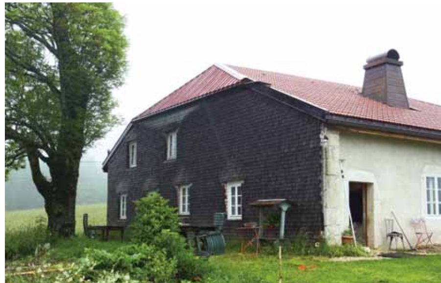
◀ Fig. 39 – Bardage en tavillons et frêne en façade sud-ouest / murs pare-vent en façade sud-est
