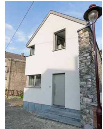
► Enchâssée entre les murs de moellons
