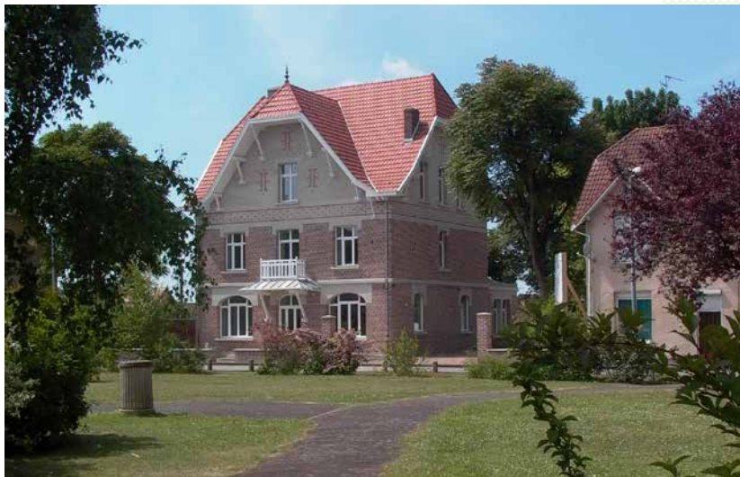
▲ L'habitation de belle prestance abrite un isolant différent par façade.
