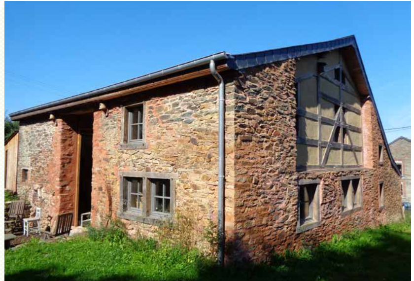
▲ Mur refait en colombage.
