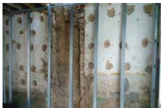
▲ Travaux d'isolation intérieure.
