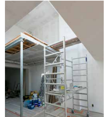
▲ Plancher recoupé pour le premier étage.
