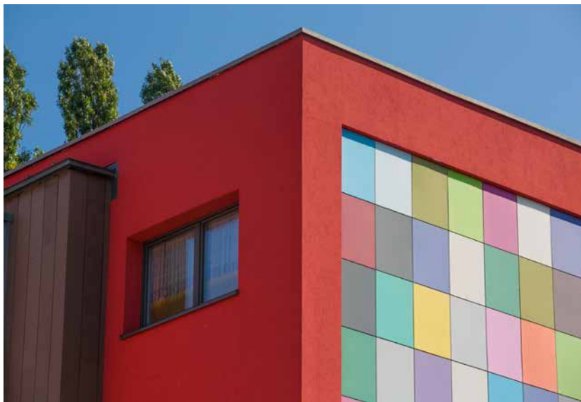
▲ Les façades sont recouvertes de 24 cm d'isolant et d'un crépis.
