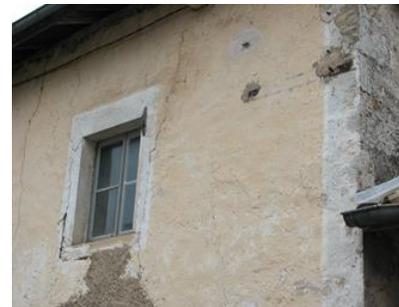
L'enduit à la chaux est imperméable à l'eau de ruissellement et protège le gros œuvre des intempéries. Il est, par contre, microporeux et donc perméable à la vapeur d'eau.
