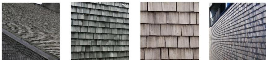
**Dans le Haut-Jura**, les façades exposées sud-ouest sont soumises à des conditions climatiques rigoureuses : exposition au vent, à la pluie et aux chocs thermiques. Les habitants ont donc protégé leurs façades avec un bardage en « tuiles de bois » appelé tavaillons ou avec un bardage métallique.
