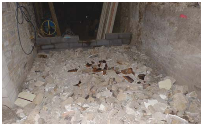
Hérissonnage d'une dalle béton en matériaux de démolition dans une maison à Forcelles St Gorgon Photo de David PELTRE et Guillermo KOHLER
