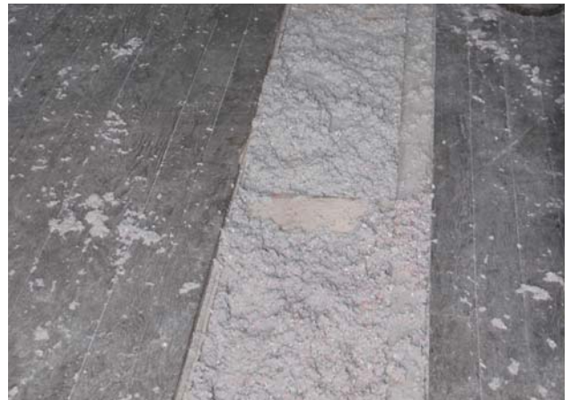
Isolation d'un plancher en ouate de cellulose, dans une maison à ÉCROUVES Photo de LUCIE BLUM et Audrey ROGEZ
