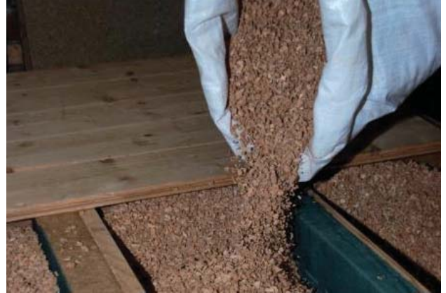
Isolation d'un plancher en granulés de liège, dans une maison à CHALIGNY Photo de Marine FOURNIS et Lorine ROLET
