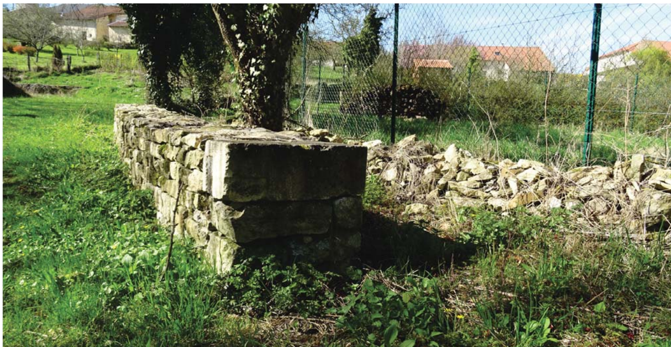
Muret en pierres sèches de récupération à BATTIGNY © Pays Terres de Lorraine
