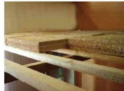
Isolant d'un plancher acoustique avec des briques de chanvre (photo Sauvageot)
