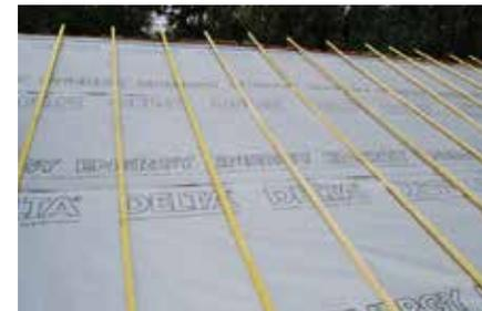
Pose de l'écran de sous-toiture, après l'isolation des rampants
