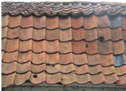
Toitures couvertes de tuiles flamandes anciennes à double courbure, en forme de S aplati, devenues rares
