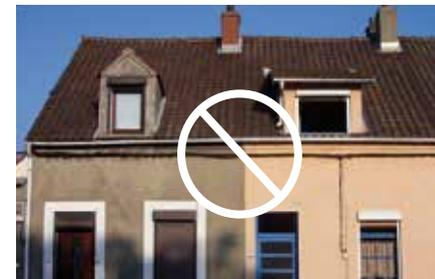
La lucarne d'origine a été remplacée par une lucarne plus large que haute. La cohérence de l'ensemble est rompue
