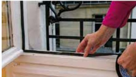
Des gestes simples pour améliorer l'étanchéité à l'air : installation de joints d'étanchéité en périphérie de l'ouvrant, et entre l'ouvrant et le dormant
