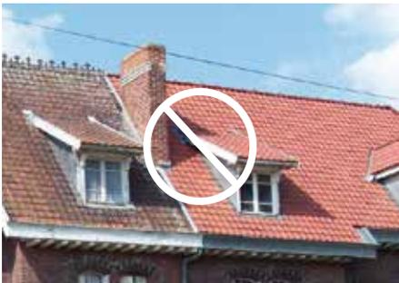
L'épi de faîtière et la crête faîtière, encore visibles à gauche, ont disparu lors de la réfection de la couverture à droite
