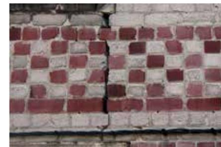
Fracture provoquée par des mouvements de sol
