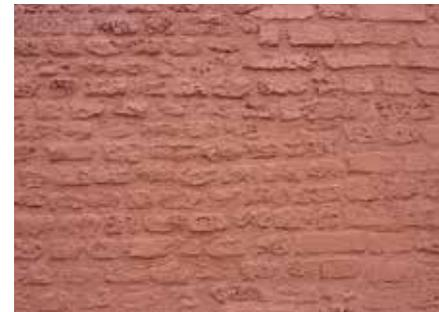
Le badigeon à la chaux protège et laisse respirer la maçonnerie
