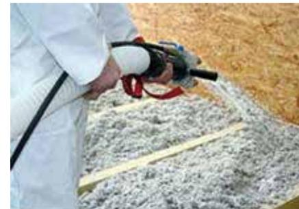
Mise en place d'une isolation en ouate de cellulose en plancher ou comble perdu
