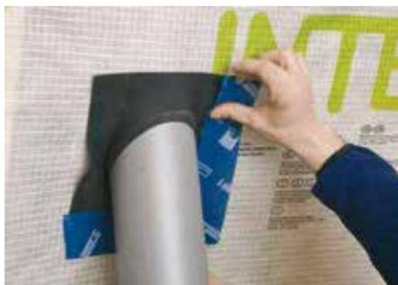
Il est nécessaire d'utiliser des adhésifs adaptés aux canalisations, sorties de ventilation, etc.
