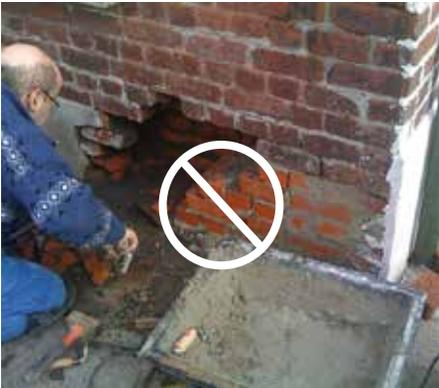
Réparation avec des briques industrielles rejointoyées au ciment, sur une façade en briques moulées à la main et rejointoyées à la chaux
