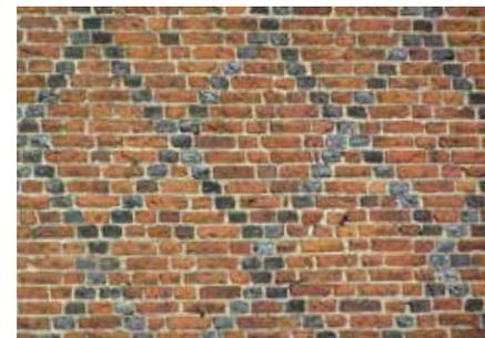
Maçonnerie avec des briques vernissées, panneresses et boutisses alternées, dites flamand ou appareillage losangé
