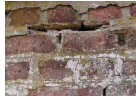
Les dégradations se poursuivent au-dessus du soubassement rejointoyé au ciment.
