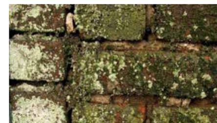
Maçonnerie saturée par l'humidité, couverte de mousses
