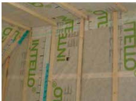
L'application d'un frein-vapeur est importante pour garantir l'étanchéité à l'air
