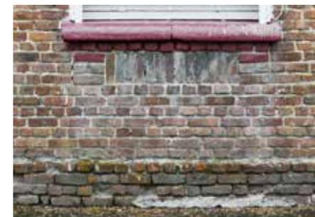
Joints vidés au pied du mur, par effet de remontées capillaires
