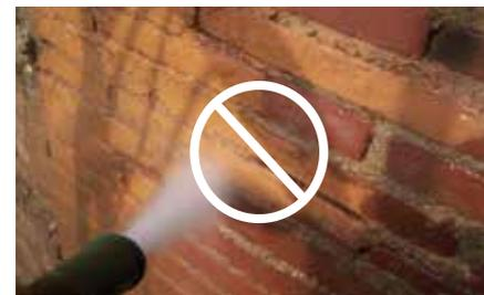
La buse trop proche de la maçonnerie et la pression trop forte provoquent un risque d'altération de la brique et des joints
