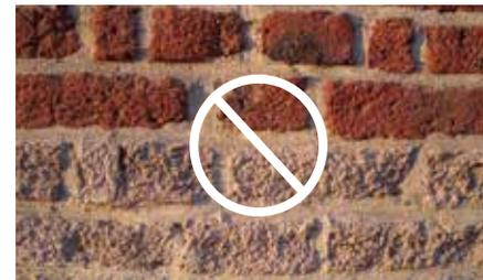
Le nettoyage par sablage à sec a complètement altéré l'épiderme de la brique
