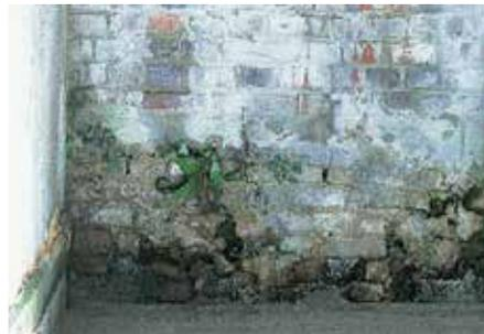
Le salpêtre se développe sous forme d'efflorescences
