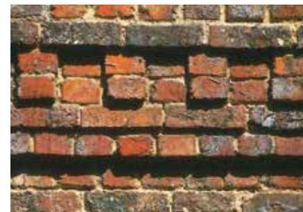
Assemblage de briques en relief, pour des corniches ou des frises
