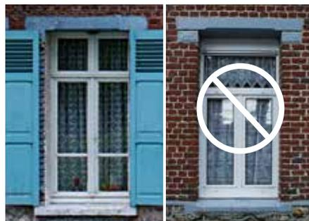
La fenêtre d'origine remplacée par une menuiserie standard : profils en PVC trop épais, perte des moulurations, traverse d'imposte plus basse...
