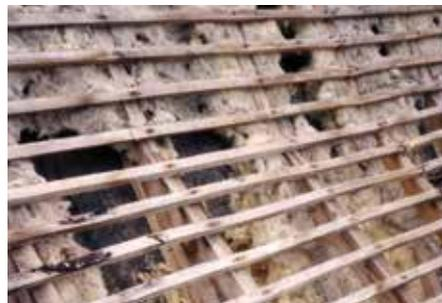
Laine de roche altérée par des infiltrations d'eau en couverture
