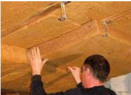
Pose d'un isolant en fibres de bois, en deux couches croisées
