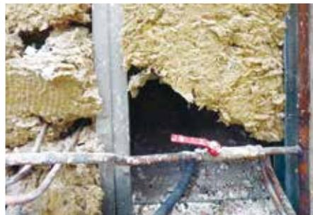
Isolation en laine de verre altérée par l'humidité. Les canalisations percent la couche isolante
