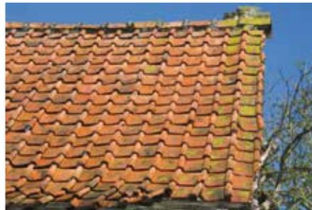
Couverture mal entretenue : glissement de tuiles, recouvrements biologiques...
