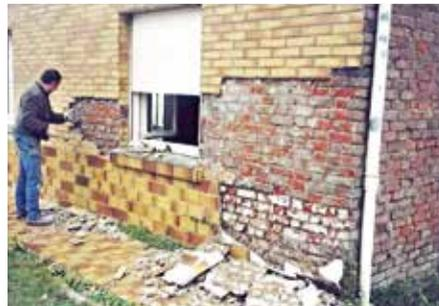
Derrière les plaquettes de fausse brique, la maçonnerie a continué à se dégrader
