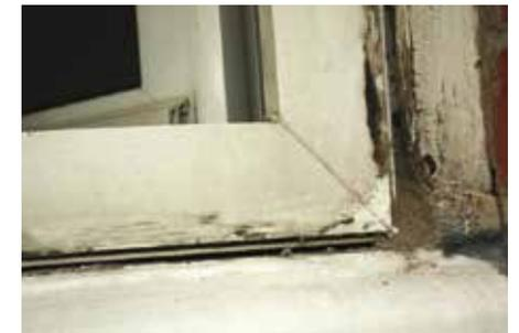
Menuiserie en PVC altérée, non réparable
