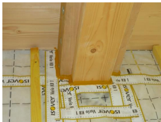
Raccordement soigné du freine-vapeur autour d'une poutre avec colle butyl
