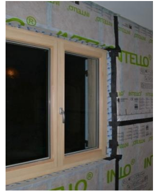
ITI sur ossature métallique avec freine-vapeur hygrovARIABLE
