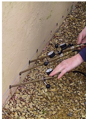
Injection de résine (Photo : dakdurieux.be)
