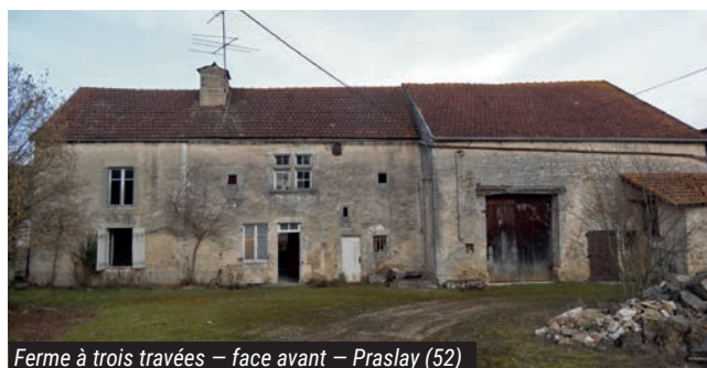
Ferme à trois travées – face avant – Praslay (52)
