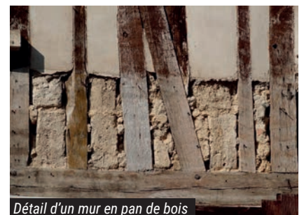
Détail d'un mur en pan de bois
