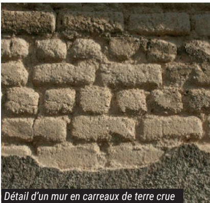
Exemple d'immeuble composé de carreaux de terre crue
