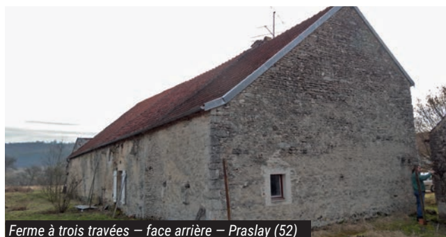
Ferme à trois travées – face arrière – Praslay (52)
