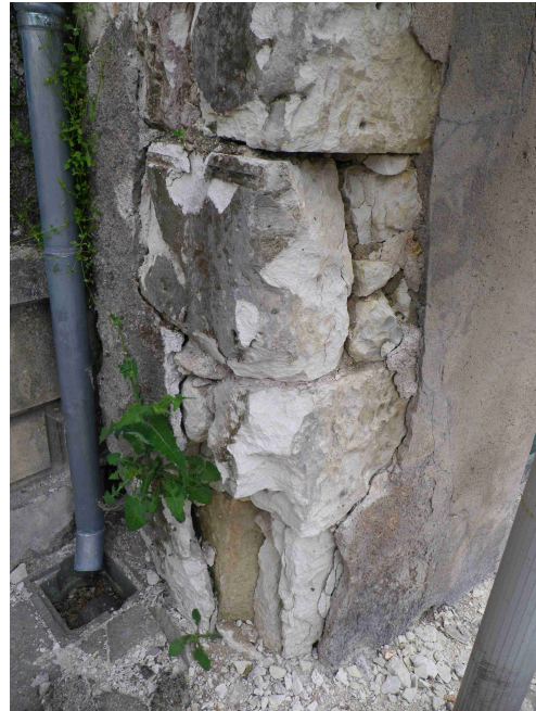
Figure 2-21 : Pierres de taille d'angle dégradées à cause de l'enduit ciment appliqué par dessus
