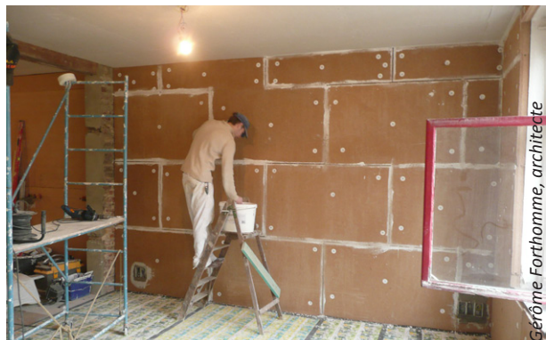
Isolation réalisée à l'aide de panneaux de fibre de bois.
