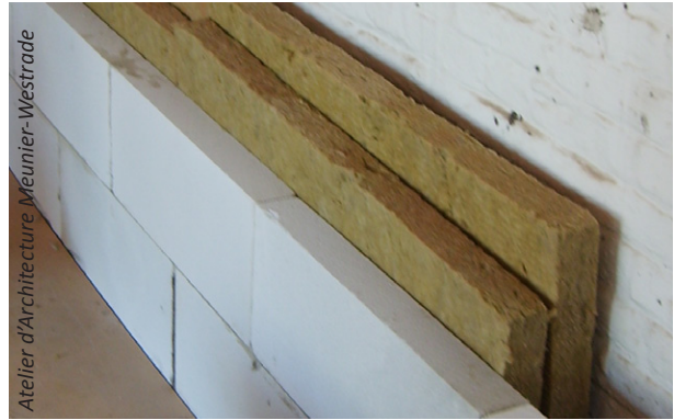
Rouleaux de laine minérale placés entre le mur existant et la nouvelle paroi intérieure constituée de blocs de plâtre.
