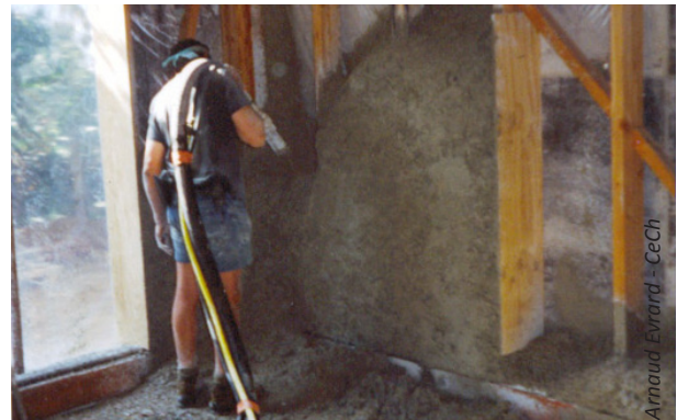
Projection d'un mélange chaux-chanvre entre des structures en bois.
