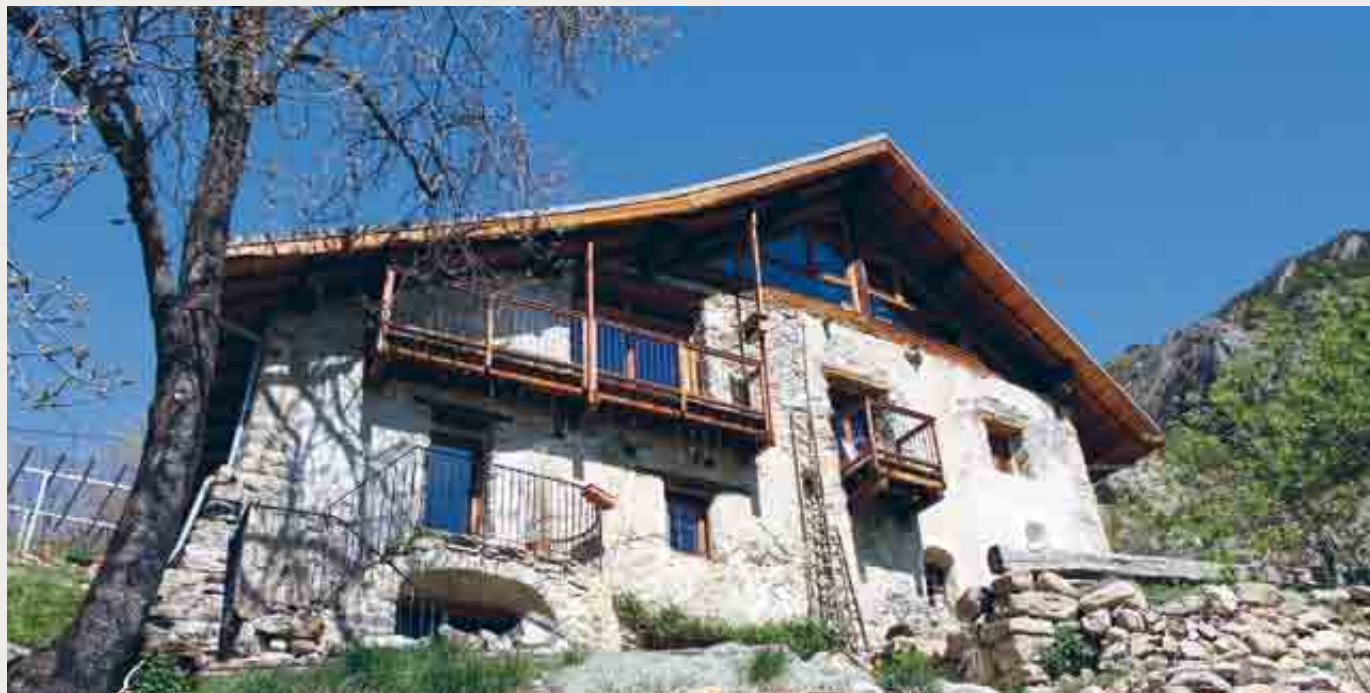
Freissinières : valorisation du solaire passif dans la réhabilitation d'une ancienne ferme : pignon vitré, balcons à montants fins laissant passer le soleil
