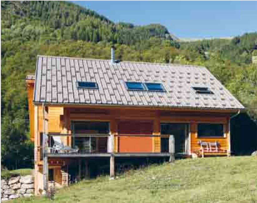
La Roche-des-Arnauds : maison en construction à ossature bois intégrant les principes du bioclimatisme : compacité et façades vitrées bien exposées
