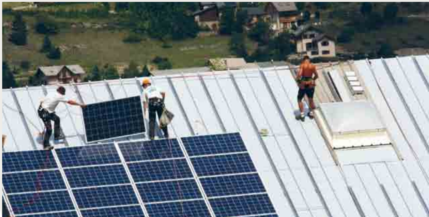
Guillestre : installation de panneaux photovoltaïques sur une toiture en bac acier
