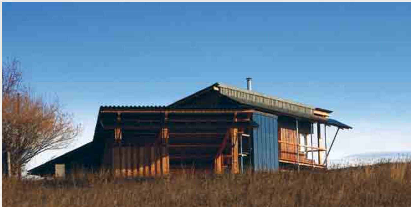
Basse Corréo, La Roche-des-Arnauds : capteurs solaires verticaux, et en auvent avec une fonction de brise-soleil
