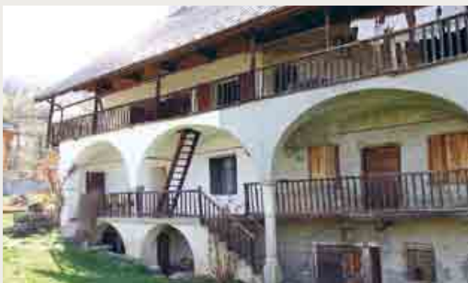
Puy-Saint-Vincent : ancienne ferme de la Vallouise, vastes galeries abritées face au sud Saint-Véran : toitures à faible pente en lauzes, axes des faitages orientés
